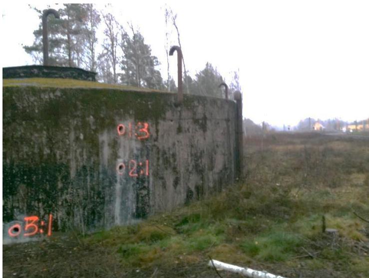
Bild 5. Tjärbehållaren med 3 olika provtagningshöjder
