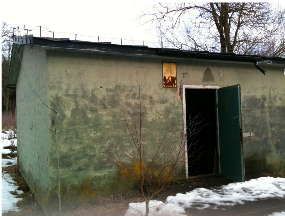
Bild 1. Förråd bestruket med tjära på insidan och grunden
