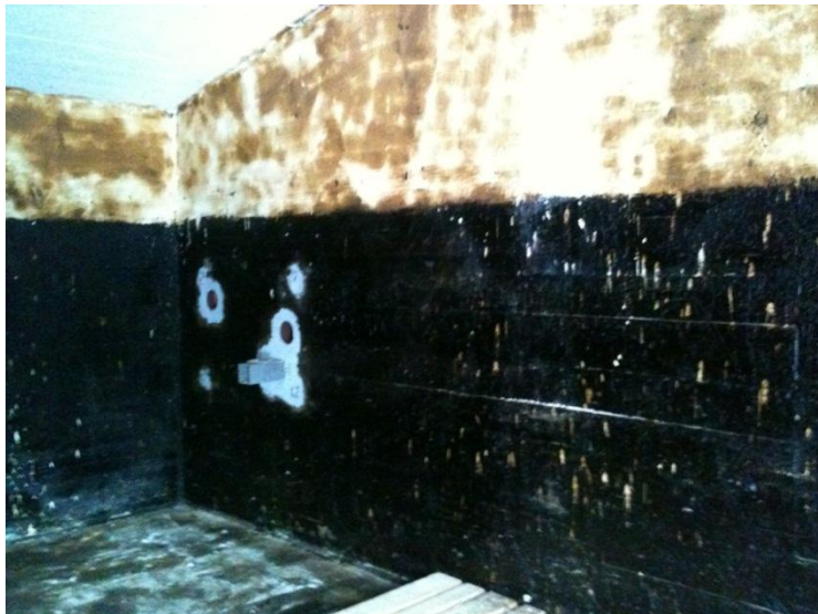
Bild 4. Ytskikt av betongförråd behandlat med tjära
